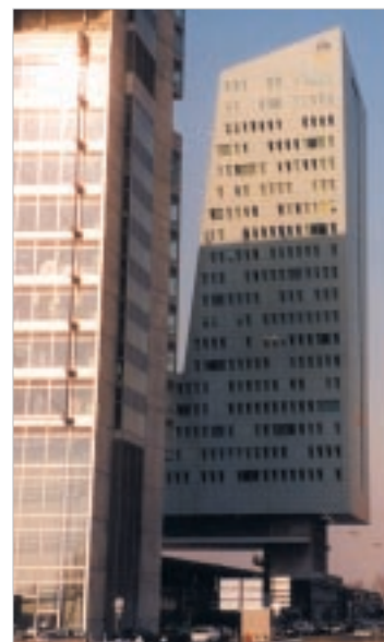
7. Euralille : la tour Lilleurope (C. Vasconi, J.-C. Burdèse, arch.) et celle du Crédit Lyonnais (Ch. de Portzamparc, E. Decaux, arch.)
