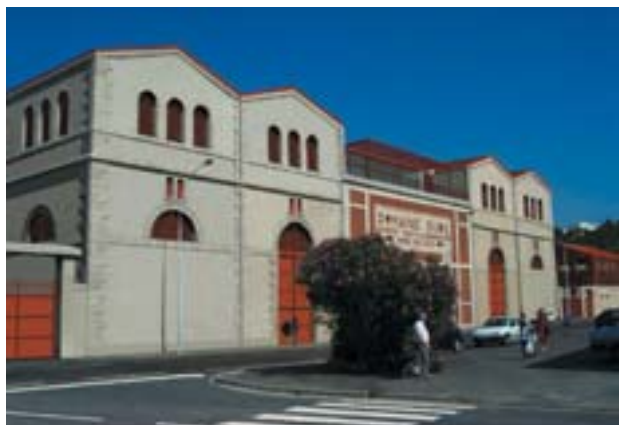
2. Une friche industrielle convertie en data center pour LD Com à Marseille
