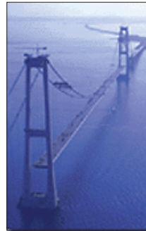
1. Le pont suspendu du Storebælt
