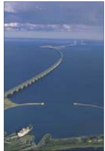
2. L'ensemble de l'ouvrage vu de l'ouest (Fionie)
