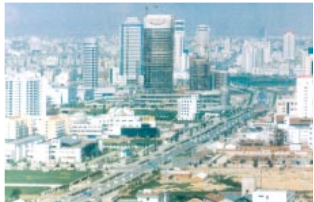
7. Suzhou New District : les gratte-ciel du secteur administratif et financier
