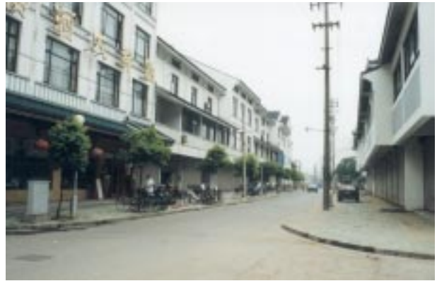
5. Quartier reconstruit : habitations dans les étages et commerces au rez-de-chaussée
