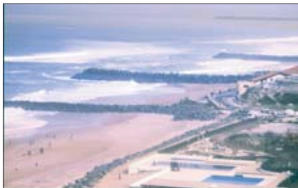
4. Défense par épis (ouvrages massifs en ophite) à Anglet (Pyrénées-Atlantiques)
