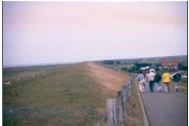
1. Une digue de défense (côte danoise). Devant la digue, parcs de sédimentation (gain de terre) ; en arrière, polders
