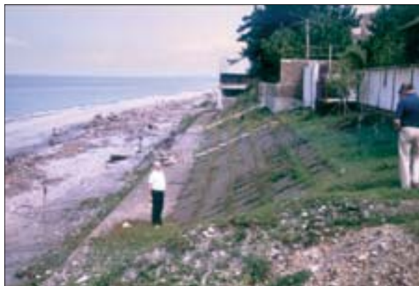
6. Un exemple de rechargement par galets (côte de la Géorgie). Devant l'ancien mur de défense, la plage rechargée en galets
