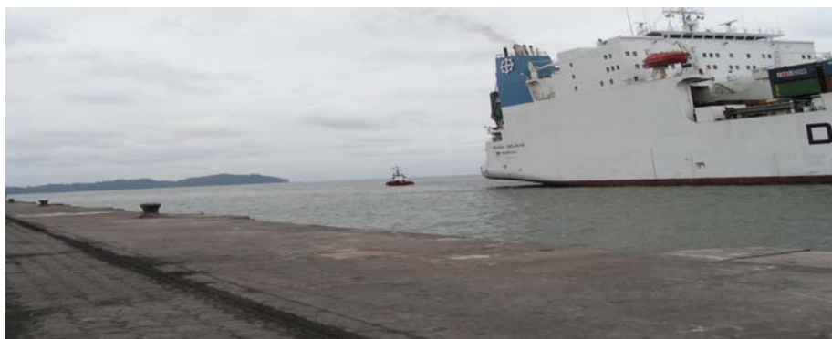
Photo 1 - Vue partielle de l'appontement commercial d'Owendo
