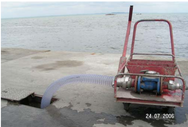
Photo 9 - Raccordement des tuyaux dans la vanne de la bouche d'évacuation d'eau et dans celle du navire
