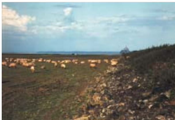
3. La digue septentrionale de la concession accordée à la Compagnie des polders de l'Ouest. Cette digue rectiligne se dirige vers le nord du Mont-Saint-Michel (cliché X. Pasco)
