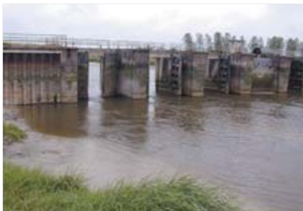
4. Le barrage de la Caserne. Il comporte des passes munies de portes à flot qui se ferment sous la pression du courant et interdisent la pénétration des eaux salées dans le fleuve. Lors de la prise de vue, la marée descend et les eaux s'écoulent vers la mer (cliché F. Verger)
