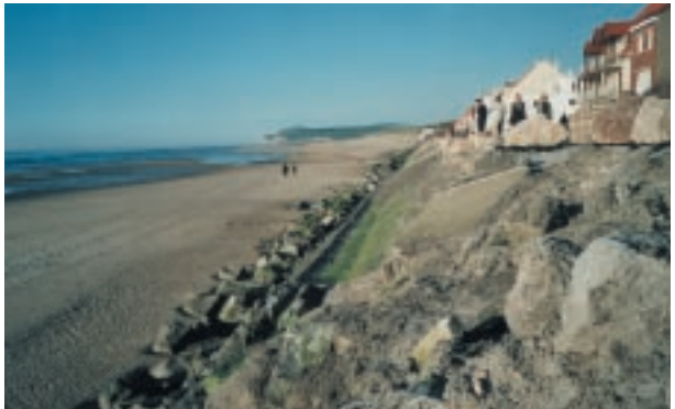
5. La digue après les travaux de réfection d'urgence en 2000 (cliché O. Cohen)
