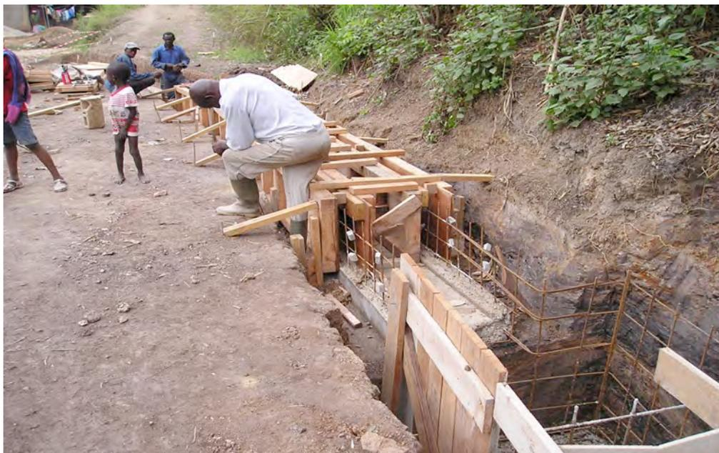
Cliché F. ALLOGHO, septembre 2003 quartier Avéa (Libreville). Ici, trois ouvriers sont en train de construire un caniveau avant de poser les pavés. Cette tranchée va permettre d'évacuer les eaux usées et pluviales. Le matériel utilisé est composé de planches, des lattes et des fers à béton. Une équipe creuse, une autre enlève la terre. Les ouvriers sont employés par une PME locale et ces derniers ont bénéficié de la formation pour la pose des pavés, formation assurée par le PAPSUT.
