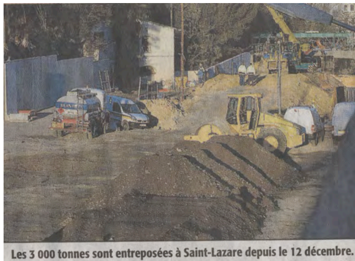
Photo 32 : Dépôts de mâchefers à Montpellier
